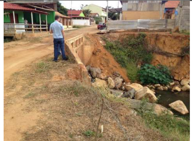
b- Principal ponte de acesso à Vila Neitzel em (detalhe dos resquícios do evento anterior) Fonte: SHS (2015)
