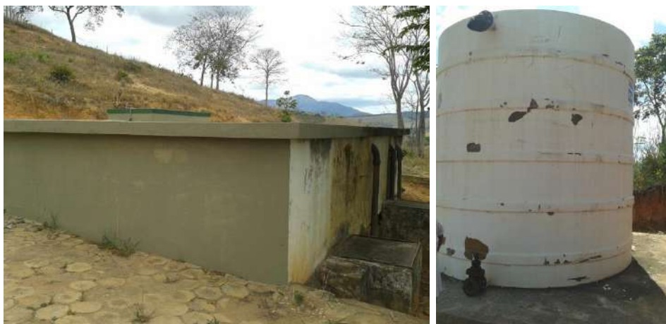
Figura 6 - Reservatórios de água tratada de Quatituba
