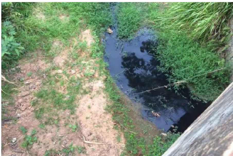
Figura 60 - Lançamento de esgoto in natura em ponto a montante da sede do município
