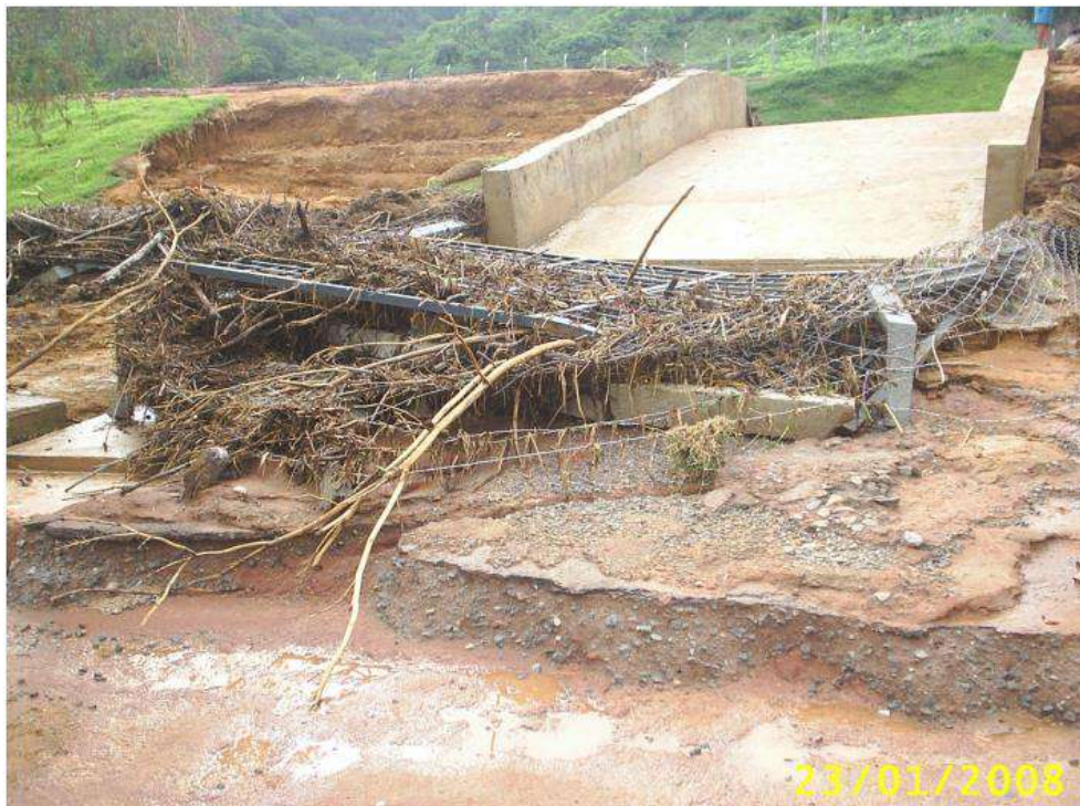
Figura 47 - Detalhe do vertedouro da barragem e os danos ocasionados pelo extravasamento
