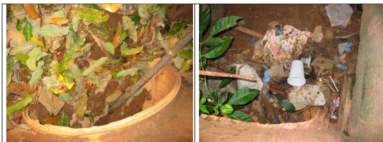
Figura 41 - Microdrenagem com obstruções
