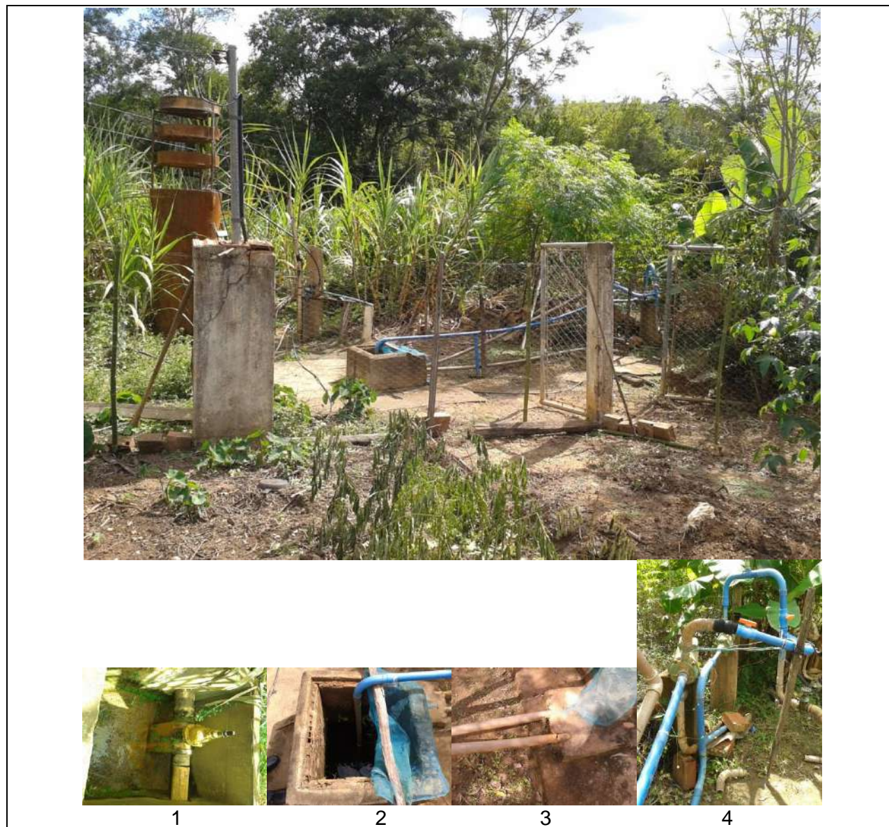
Figura 8 - Captação de água da Vila Neitzel
