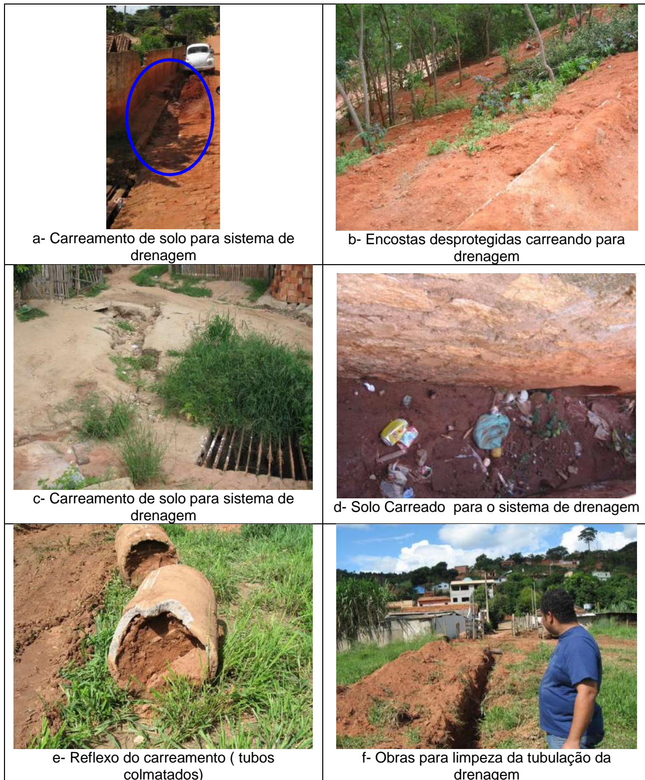
Figura 38 - Colmatção da rede de micro drenagem de Quatituba
