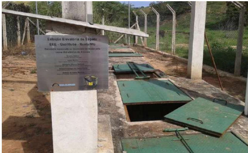
Figura 15 - Estação Elevatória de Esgoto de Quatituba
