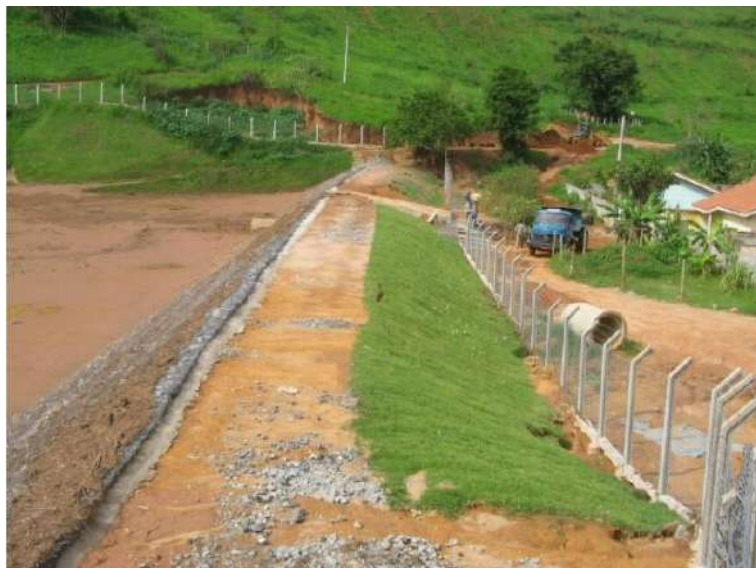
Figura 46 - Vista longitudinal da barragem extravasada
