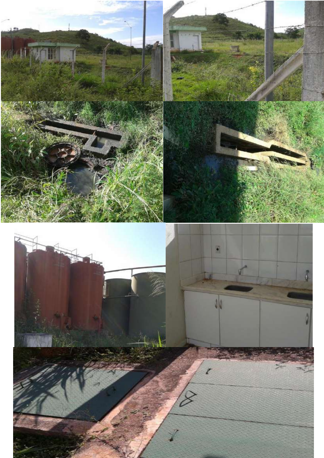
Figura 17 - Estação de Tratamento de Esgoto de Itueta
