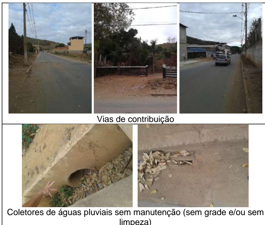
Figura 35 - Problema de microdrenagem no final da rua Santo Antônio
