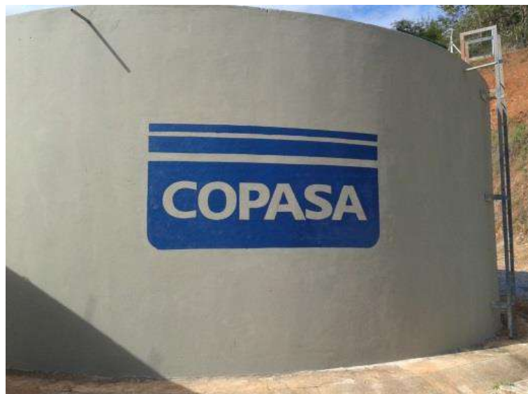
Figura 4 - Reservatório de água tratada de Itueta
