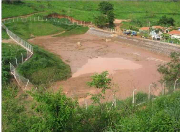
Figura 45 - Vista geral da barragem para retenção de águas pluviais e de sua bacia de acumulação, observando-se a proximidade das casas da área urbana de Itueta/MG
