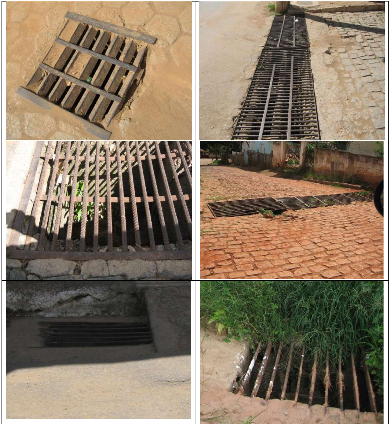
Figura 37 - Tipos de dispositivos coletores encontrados em Quatituba
