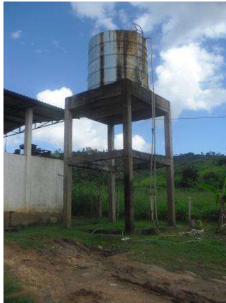
Figura 9 - Reservatório elevado da Vila Neitzel
