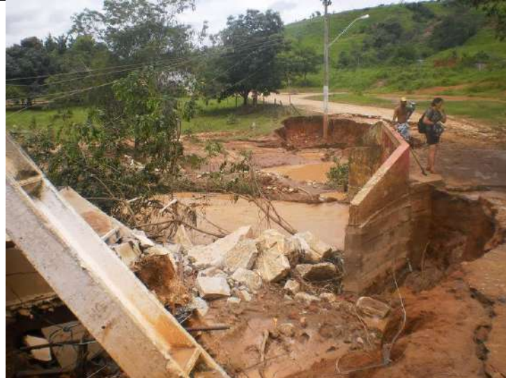
c- Principal ponte de acesso sul, sobre o Córrego do Juazeiro visto de outro ângulo após evento Fonte: Jornal O Regional (2014)
