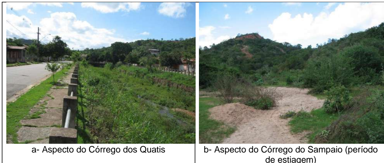
Figura 56 - Assoreamento nos corpos hídricos da sede municipal de Itueta
