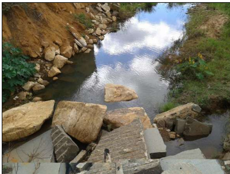
Figura 57 - Destroços de construções no leito do rio (primeiro plano), erosão das margens dos rios (segundo plano).
